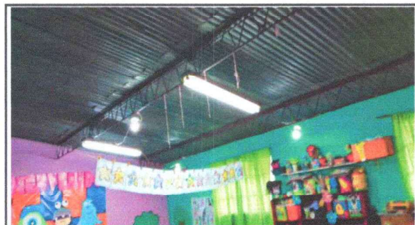
Foto 3: Sustitución de estructura de techo área de aula 2
