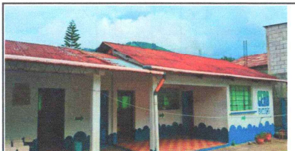
Foto 4: Sustitución de bajada de aguas puviales.
