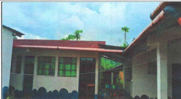
Foto 2: Sustitución de láminas para area de cocina y baños de 9.5*5 mts equivalente a 47.5mts2
