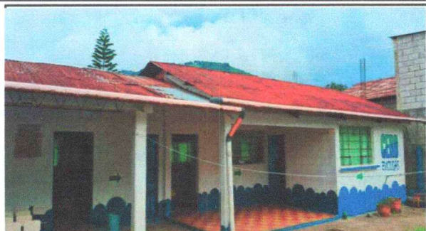
Foto 1: Sustitución de cubierta de lámina en 2 aulas con un área de 10.5*22 mts equivalente a 231 mts2
